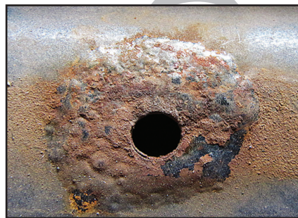
Фото 2.3. Коррозионное вздутие вокруг отверстия под пластмассовый пистон.
